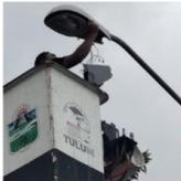
CAMBIO DE LUMINARIA OBSOLETA POR LED DE 100 W. FRACC. PALMAS
